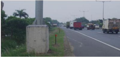
(a) Hazard objek tunggal tiang rambu sekitar 70 centimeter dari tepi bahu
