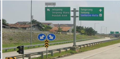
(b) Hazard objek tunggal tiang petunjuk arah tepat di tepi bahu jalan. Pagar Keselamatan sama sekali tidak membuat perlindungan terhadap arus jalur utama
