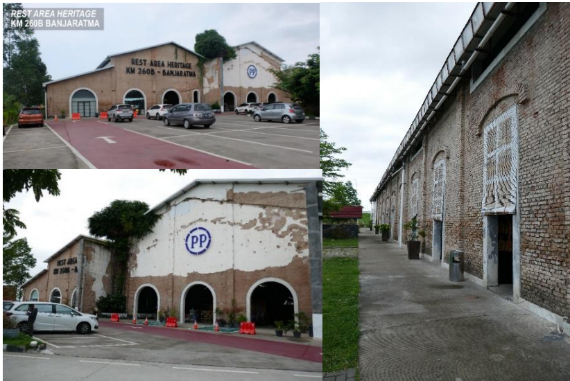
Gambar 8 Bangunan Heritage Eks Pabrik Gula Rest Area KM 260B Banjartma
