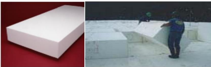
Gambar 11 Blok EPS untuk Timbunan Ringan
