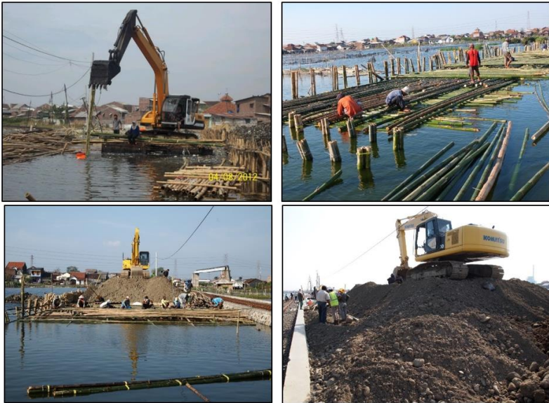
Gambar 6 Konstruksi Matras Cerucuk Bambu
