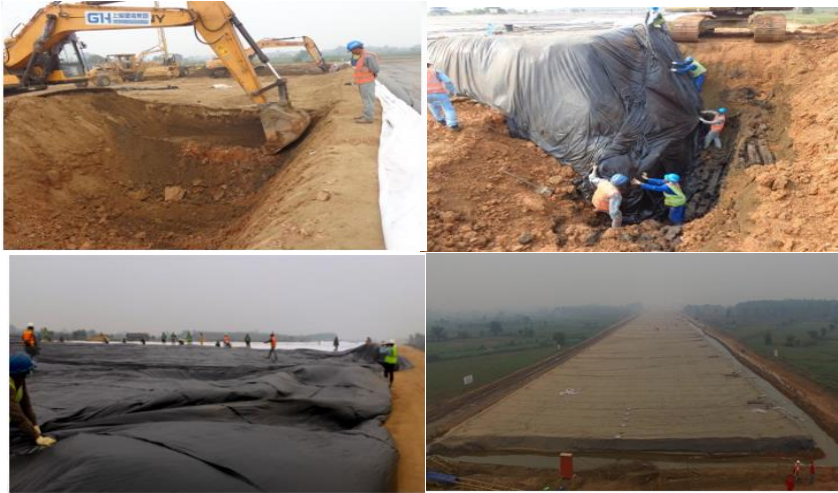
Gambar 11 Proses Pemasangan Geomembran
