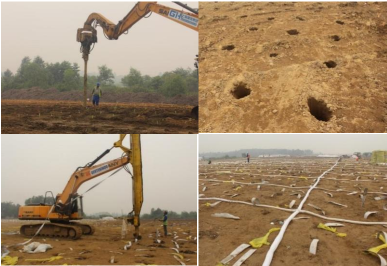
Gambar 10 Pemasangan PVD dan PHD pada Pekerjaan Vacuum
