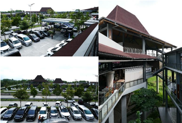
Gambar 17 Fasilitas Parkir di Kedua Sisi Jalan Tol
