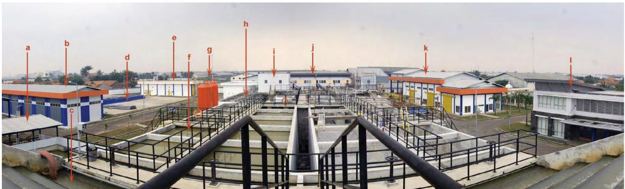
Gambar 9. IPA Sepatan a. Tangki Lumpur; b. Rumah Pompa Air Minum; c. Aerator; d. Reservoir; e. Bangunan Chlorine; f. Ruang Pengadukan; g. Anti *Water Hammer*; h. *Tube Settler*; i. Rumah Poma Pulsetube; j. Galeri Filtrasi; k. Bangunan Bahan Kimia; l. Gedung Operasional)
