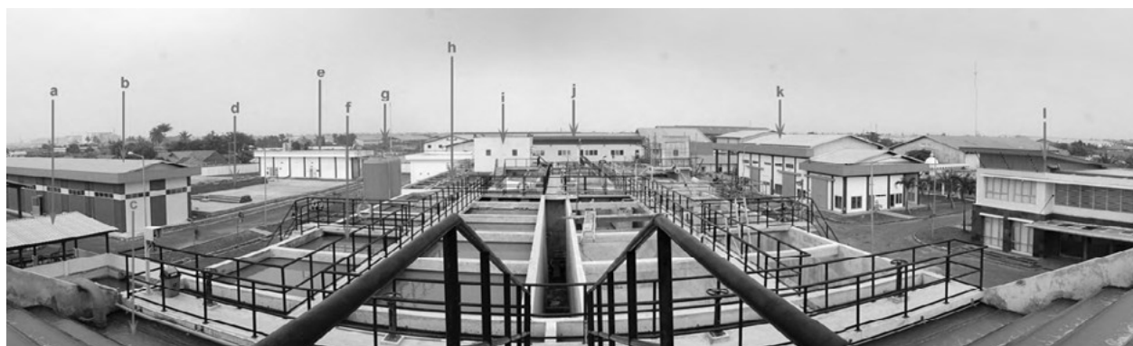
Gambar 9. IPA Sepatan: Tangki Lumpur (a); Rumah Pompa Air Minum (b); Aerator (c); Reservoir (d); Bangunan Chlorine (e); Ruang Pengadukan (f); Anti Water Hammer (g); Tube Settler (h); Rumah Poma Pulsetube (i); Galeri Filtrasi (j); Bangunan Bahan Kimia (k); Gedung Operasional (l)
