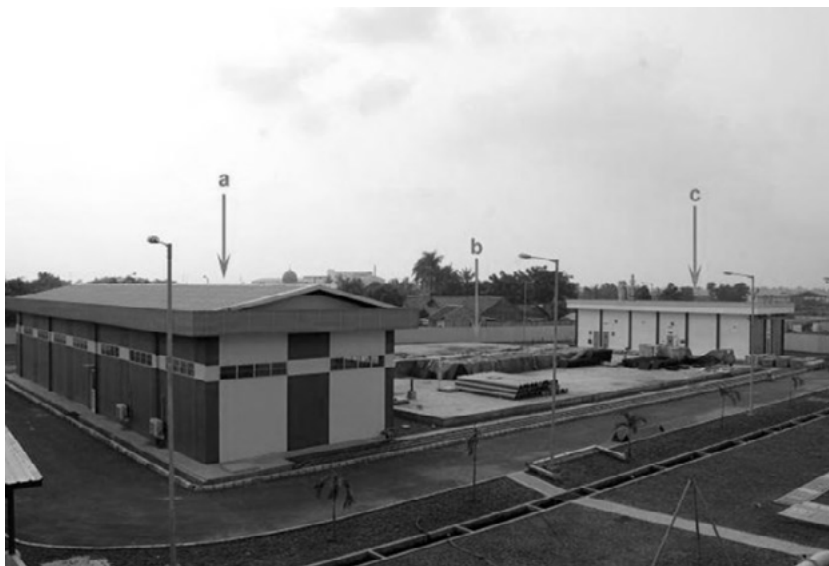
Gambar 6. Rumah Pompa (a), Reservoir Air Baku (b), dan Gudang Chlorine (c)
